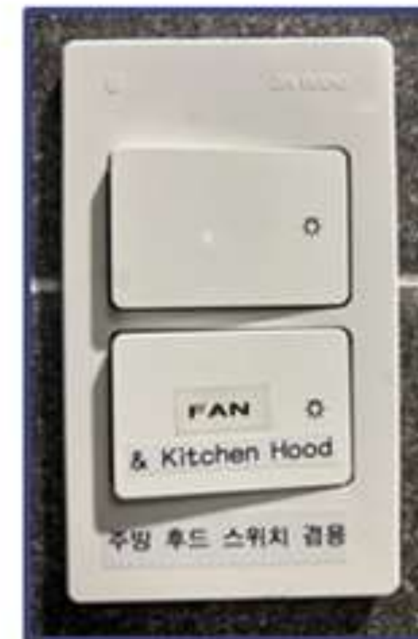
[ 지하 1층 샤워실 ] [ B1 shower room ]
