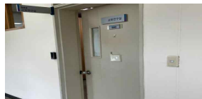
교육연구실(502호) 출입문 시창 설치 (양호)
