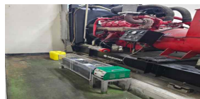
예비발전설비 배터리 커버 설치 (양호)
