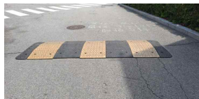
건물 주변 도로 과속방지시설 설치 (양호)
