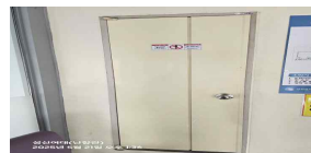
EPS/TPS실 점검구 상태 (양호)
