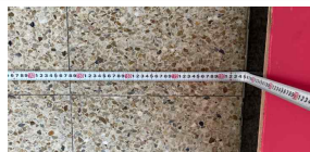
6층 복도 유효너비 확보 (양호)
