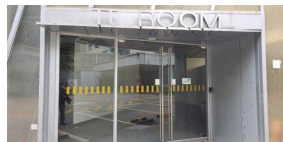
출입문 상부 캐노피 관리 상태 (양호)
