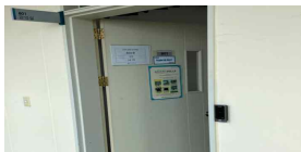
ALC강의실(801호) 출입문 시창 설치 (양호)
