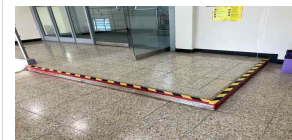
3층 복도 바닥 단차이 상태 (양호)
