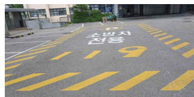
소방차전용주차구역 설치 (양호)
