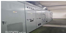
수변전실 침수감지기 및 경보시스템 미설치 (미흡)
