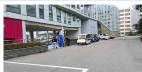
정면 비상 차량 진입로 확보 (양호)
