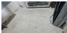
EPS/TPS실 바닥분진 관리상태 (양호)
