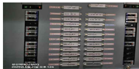
분전반 이중보호덮개, 사용위치명 부착 (양호)
