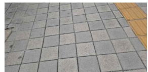
보행로 보도 파손, 돌출, 침하 없음 (양호)
