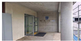
보행로 보차분리 상태 (양호)
