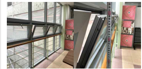
복도 창호 추락방지 조치 상태 (양호)
