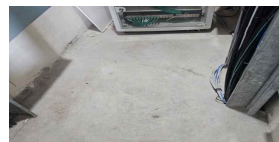
EPS/TPS실 바닥분진 관리상태 (양호)
