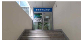
출입문 상부 캐노피 관리 상태 (양호)
