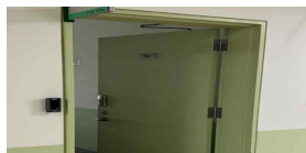
휴게실(304호) 출입문 속도제어장치 설치 (양호)
