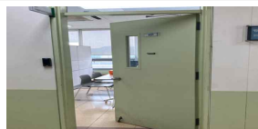
사무실(401호) 출입문 시창 설치 (양호)
