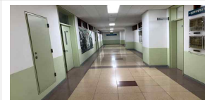
2층 복도 바닥 단차이 상태 (양호)
