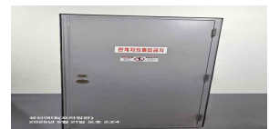
EPS/TPS실 점검구 상태 (양호)
