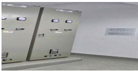
수변전실 침수감지기 및 경보시스템 미설치 (미흡)
