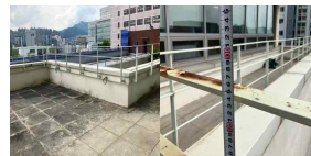
발코니 추락방지 난간 높이 (양호)
