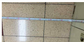
5층 복도 유효너비 확보 (양호)
