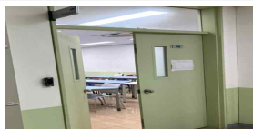
SDE 실습실(408호) 출입문 시창 설치 (양호)
