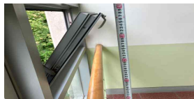
복도 창호 추락방지 조치 상태 (양호)
