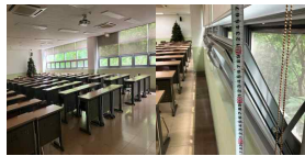
강의실 창호 추락방지 조치 (양호)
