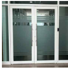
7층 연구실 출입문 강화유리 사용 (양호)
