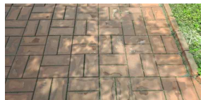
보행로 보도 파손, 돌출, 침하 없음 (양호)
