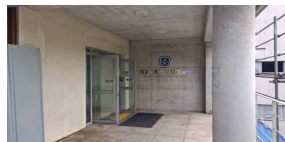
출입문 상부 캐노피 관리 상태 (양호)
