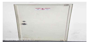
EPS/TPS실 점검구 상태 (양호)
