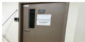
실습실(401호) 출입문 시창 설치 (양호)
