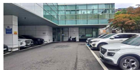
소방차전용주차구역 설치 (미흡)
