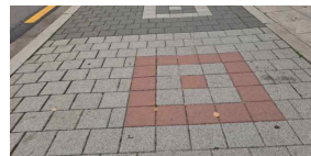
보행로 보도 파손, 돌출, 침하 없음 (양호)
