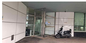
출입문 상부 캐노피 관리 상태 (양호)
