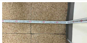
3층 복도 유효너비 확보 (양호)
