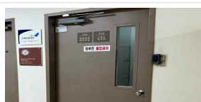
스마트창작터(508호) 출입문 속도제어장치 설치 (양호)
