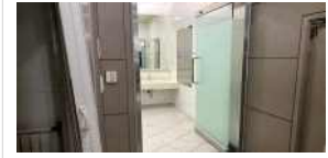
화장실 출입문 비산방지필름 부착 (양호)
