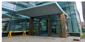
출입문 상부 캐노피 관리 상태 (양호)
