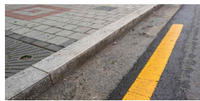
보행로 보차분리 상태 (양호)
