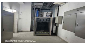
EPS/TPS실 장비이격거리 확보 (양호)
