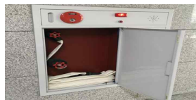
목내소화전 관리 상태 (양호)
