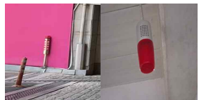
지하주차장 출입 알람시스템 설치 (양호)
