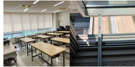
강의실 창호 추락방지 조치 (양호)
