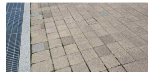
보행로 보도 파손, 돌출, 침하 없음 (양호)
