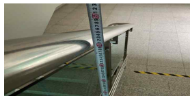
계단 난간 높이 확보 상태 (양호)
