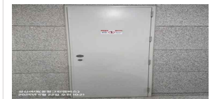
EPS/TPS실 점검구 상태 (양호)
