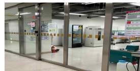
미생물실험실(754호) 출입문 시창 설치 (양호)
