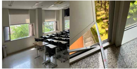
강의실 창호 추락방지 조치 (양호)
