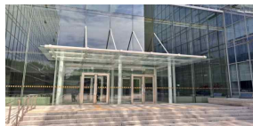
출입문 상부 캐노피 관리 상태 (양호)
