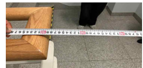
계단참 유효너비 확보 상태 (양호)
