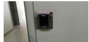
비상시 출입문 통제 (양호)
