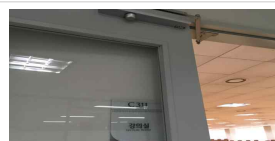
강의실(311호) 출입문 속도제어장치 설치 (양호)
