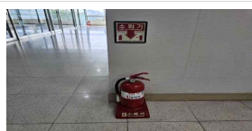
복도 소화기 관리 상태 (양호)
