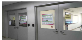
디자인실습실(645호) 출입문 시창 설치 (양호)
