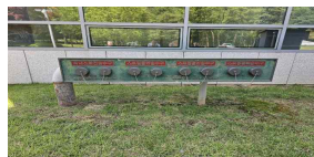
연결송수구 관리 상태 (양호)
