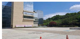
정면 비상 차량 진입로 확보 (양호)
