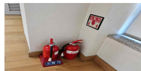
강의실 소화기 관리 상태 (양호)
