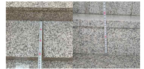
계단 단너비, 단높이 확보 상태 (양호)
