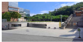
보행로 보차분리 상태 (양호)
