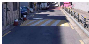
건물 주변 도로 과속방지시설 설치 (양호)
