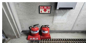
기계실 소화기 관리 상태 (양호)
