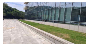
외벽 완충공간 확보 상태 (양호)
