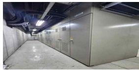
수변전실 침수감지기 및 경보시스템 미설치 (미흡)
