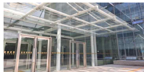
출입문 상부 캐노피 관리 상태 (양호)
