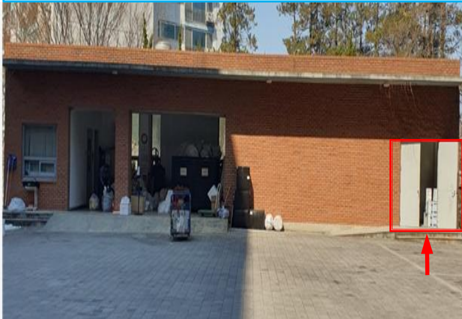
폐기물 창고 (정면)
