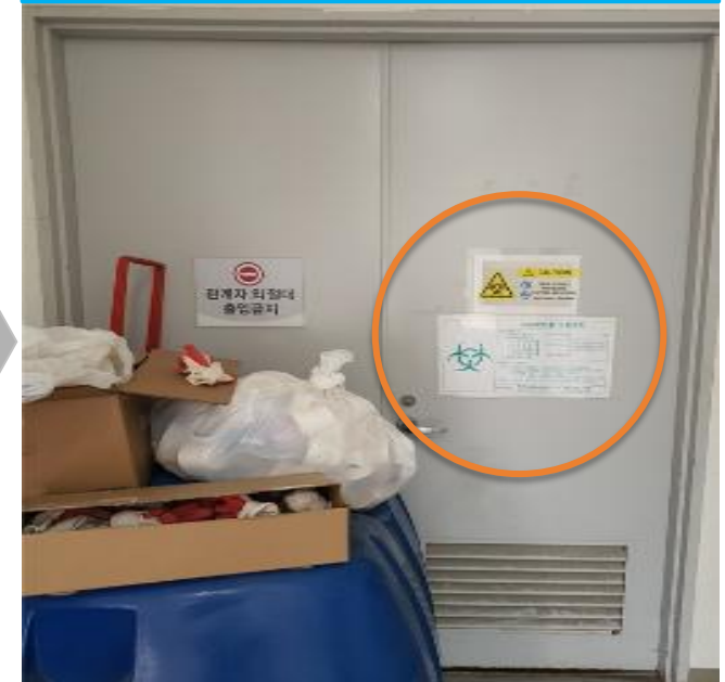
폐기물 창고 내 출입문
